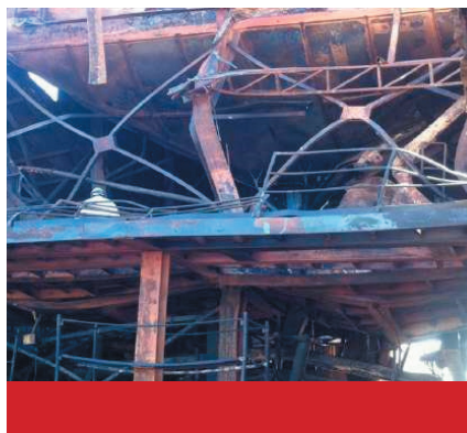
Estructura sometida a incendio real.
