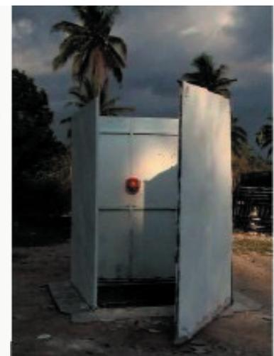
La bola ELIDE debe ser colgada en el interior del recinto a una altura de 1160 mm sobre el nivel de combustible.
