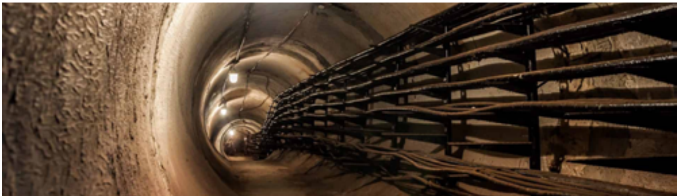
Figura 6: Ejemplo de túnel de cables
