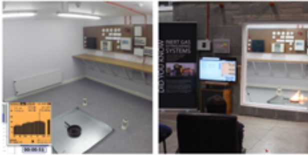
Figura 5: Ensayos de descarga de IG-541
